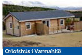
Orlofshús í Varmahlíð
